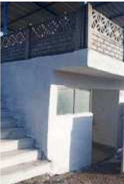
Hisaraltı Mahallesi / WC
