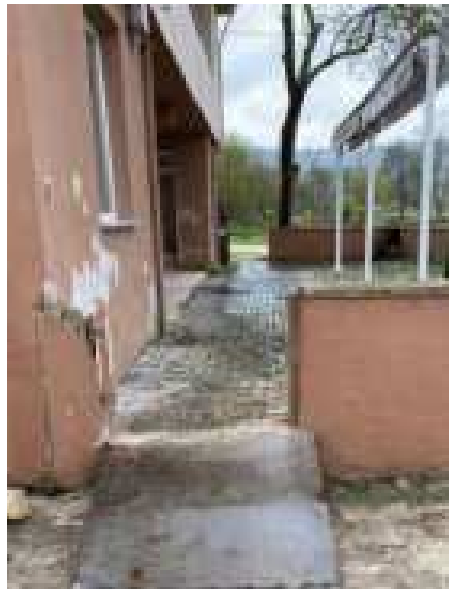
Aralık Mahallesi / Rampa
