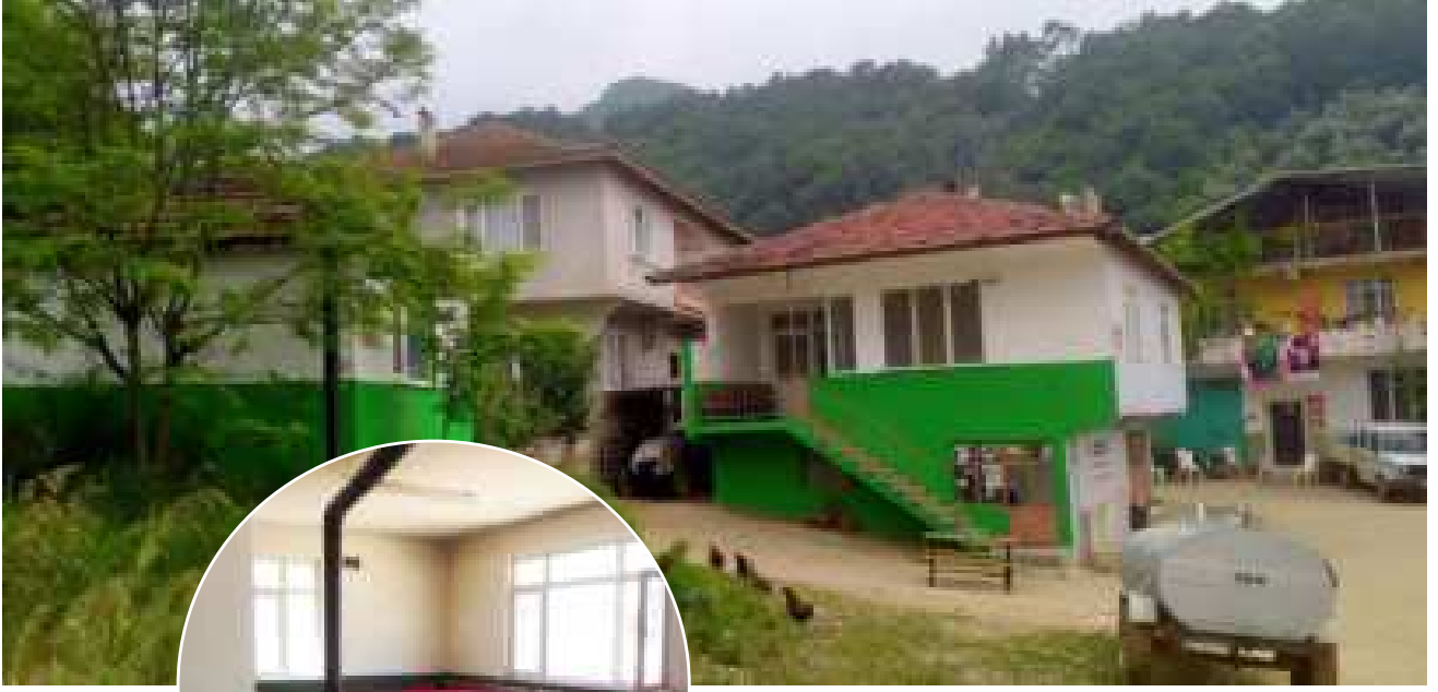
Akçapınar Mahallesinde bulunan kahvehane ve umumi tuvalette bakım ve onarım çalışmaları yapıldı.
