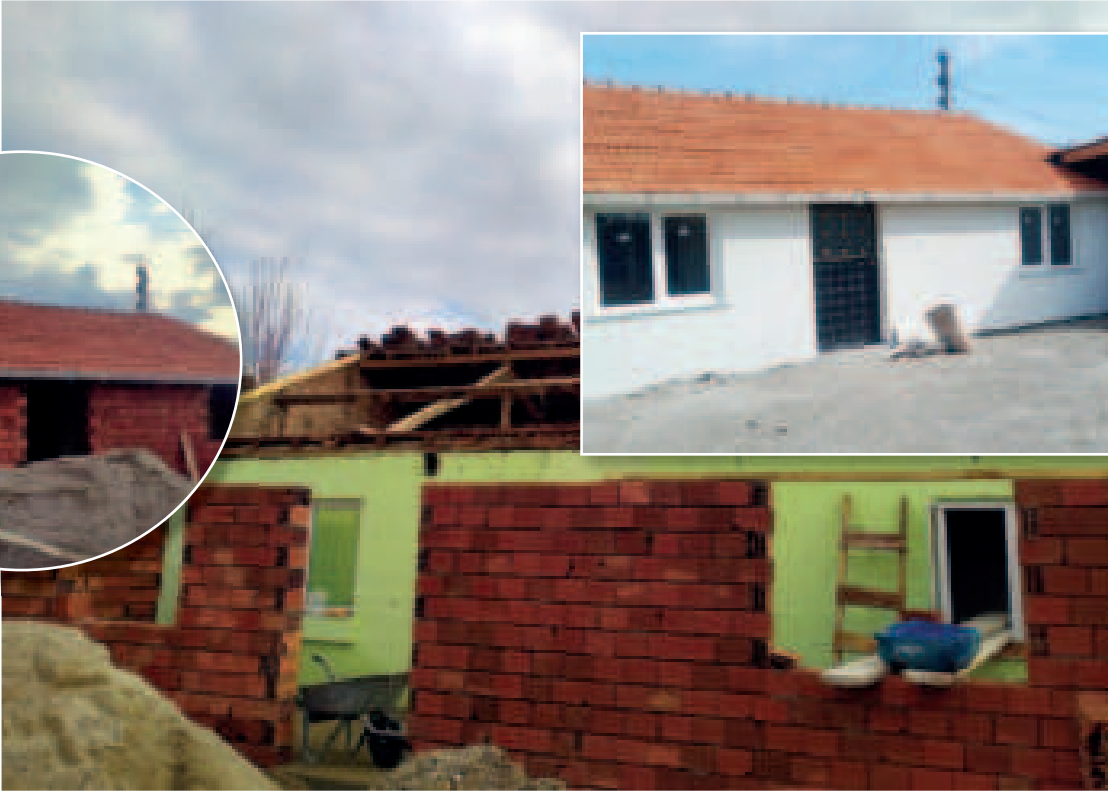
Behram Mahallesi'nde bulunan lojmanda bakım ve onarım çalışmaları gerçekleştirildi.
