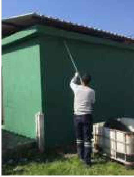
Derecik Mahallesi / WC
